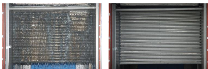
図 26 洗浄前熱交換器表面 図 27 洗浄後熱交換器表面
