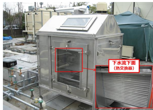
図2 流下液膜式熱交換器 (筐体の中に熱交換器を設置)
