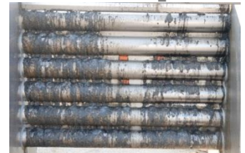
図21 ミスト洗浄実験後_12/6 10:49 (熱交換面右側 3 分間洗浄)
