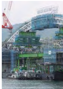
建築中の橋の様子
