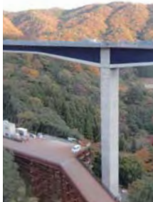
鋼とコンクリートから成る複合道路橋
